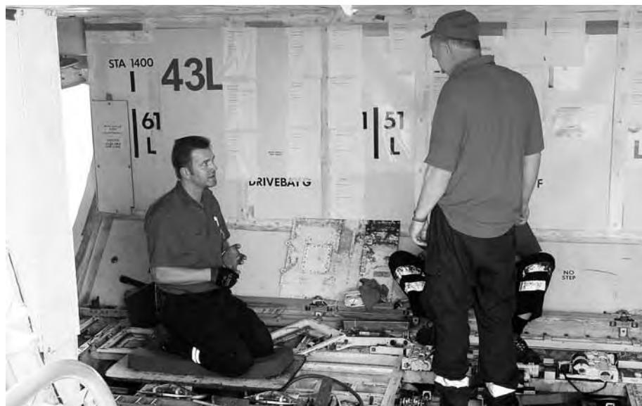
Die Mechaniker der LTU bei der Arbeit in Guayaquil. Bei bis zu 50° C wird im Frachtraum die Struktur repariert.
