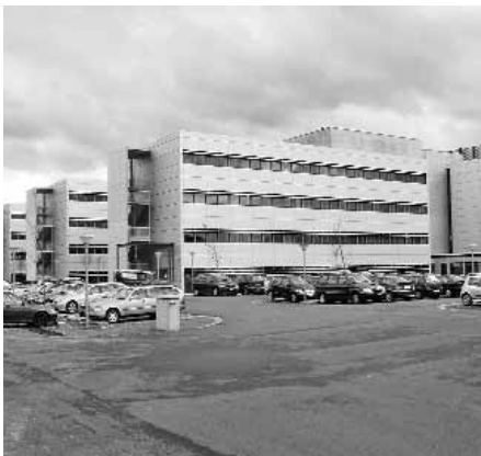
Das neue skyguide-Gebäude in Dübendorf.
