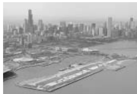
Kein Aprilscherz: Demoliertes Chicago Meigs Field am 1. April 2003
