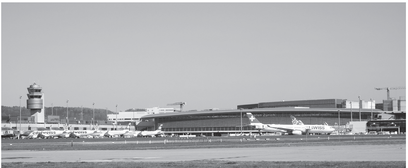
Vor dem Bau: Das gegenwärtige Dock A (links) inklusive Tower wird einem Ersatzneubau weichen.
