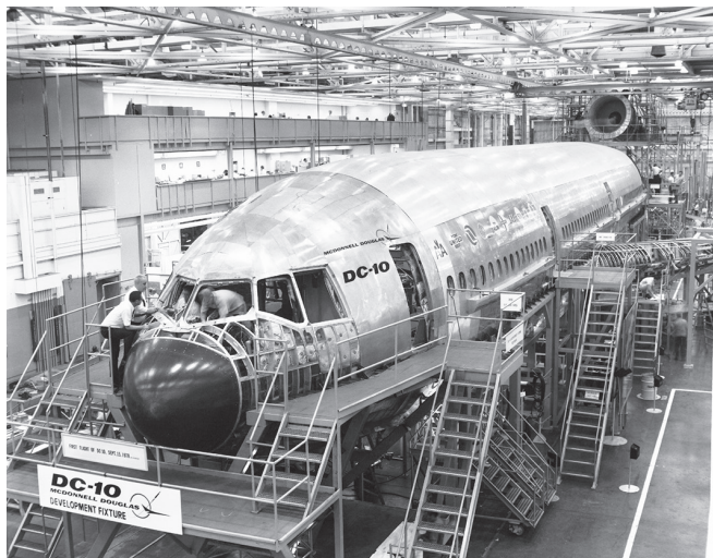
Bau der ersten Serien-DC-10.
